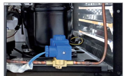
Valvola per sbrinamento a gas caldo Hot gas defrost valve
